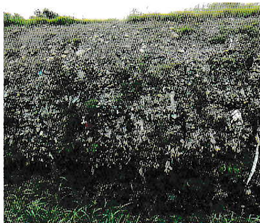
サンドイッチ工法による埋立
